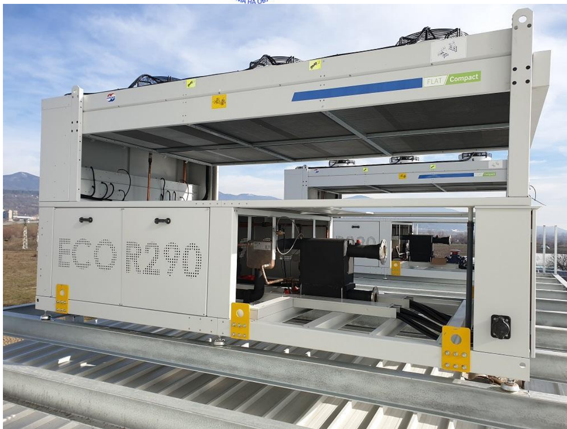
Фигура 9.2 Водоохлаждащ агрегат, работещ с R290
