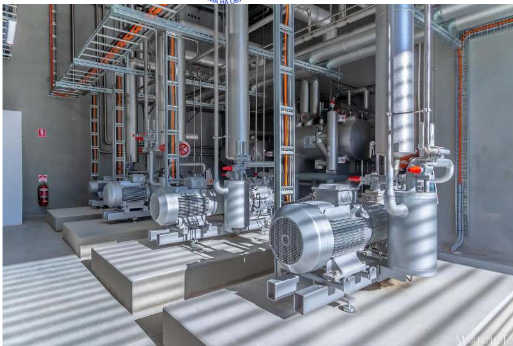
Фигура 9.6 Техническо помещение на индустриална амонячна хладилна система (източник: Scantec – www.scantec.com.au )
