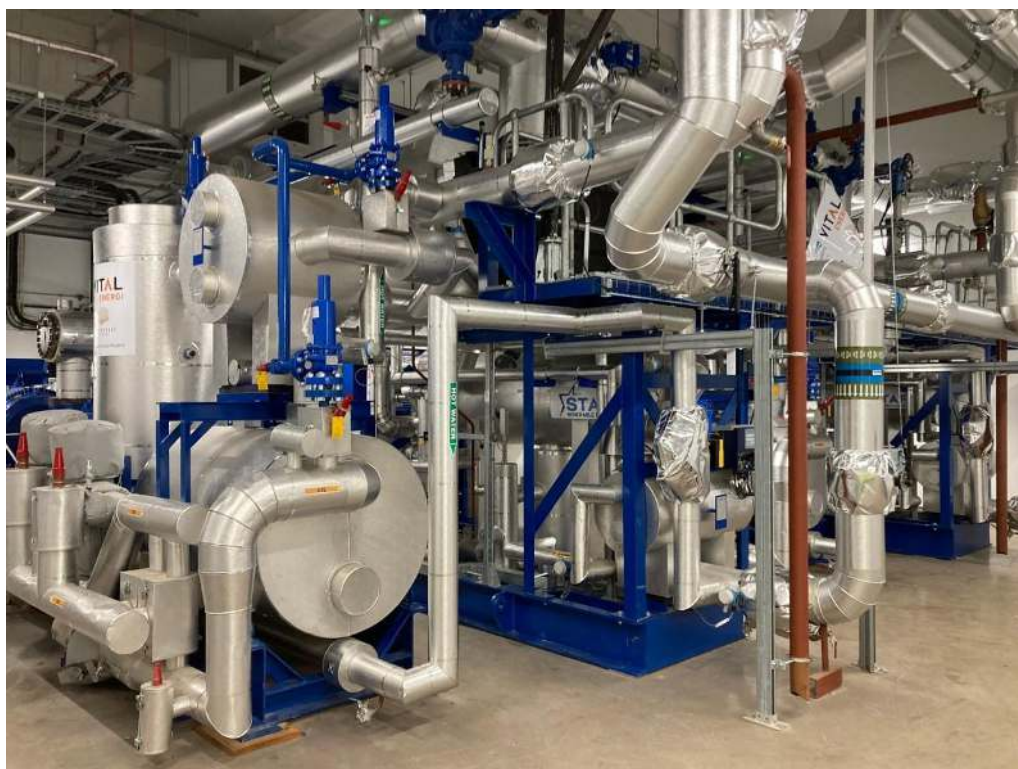
Фигура 9.7 Индустриална термопомпена система за централизирано отопление, работеща с амоняк (източник: ABB – https://global.abb/group/en )
