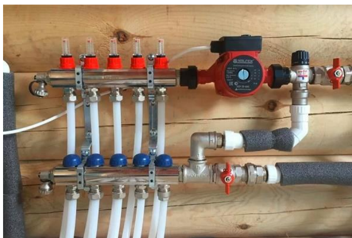
Фиг.2. Разпределителни колектори на двутръбна отоплителна система с принудителна циркулация.
